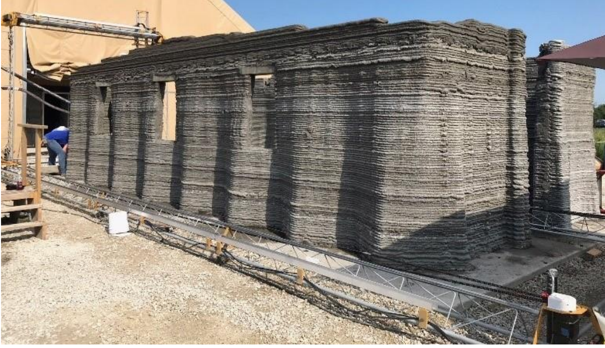
Şekil 20 – 3D basılmış bir bina
